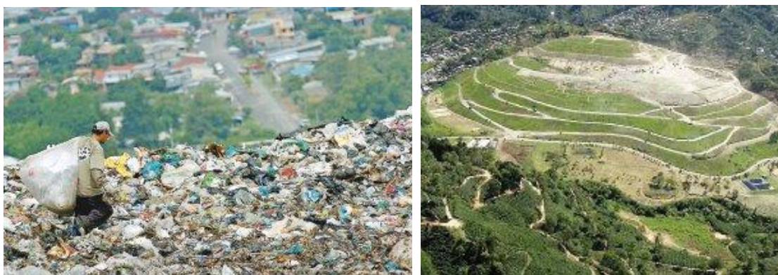
Figura 3. Visión cercana y panorámica del “relleno sanitario” de Río Azul (Fuente: Google Images)
