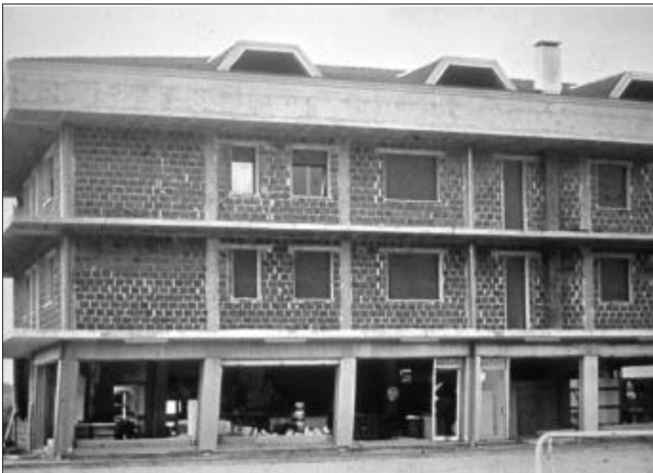
Fotografía 9. Falla en planta baja por piso suave
