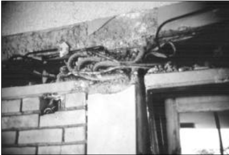
Fotografía 18. Efecto de columna corta
