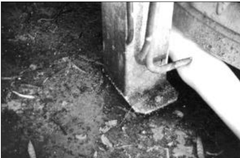
Fotografía 16. Detalle de conexión en los soportes
