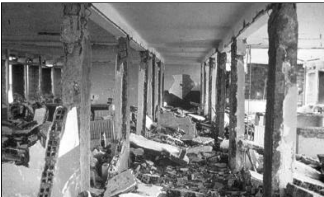
Fotografía 24. Muros destruidos por flexibilidad de la estructura
