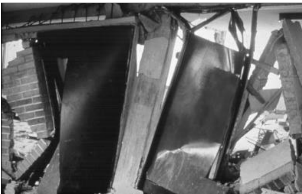
Fotografía 5. Falla de columnas por falta de sismorresistencia
