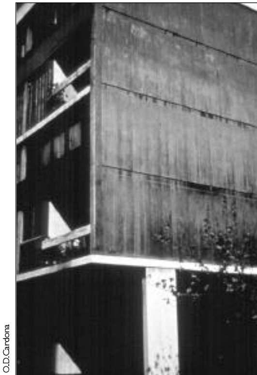
Fotografía 10. Interrupción de muro estructural en la planta baja
