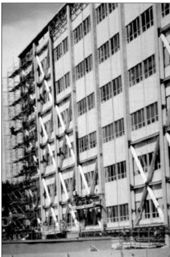
Fotografía 13. Refuerzo con diagonales
