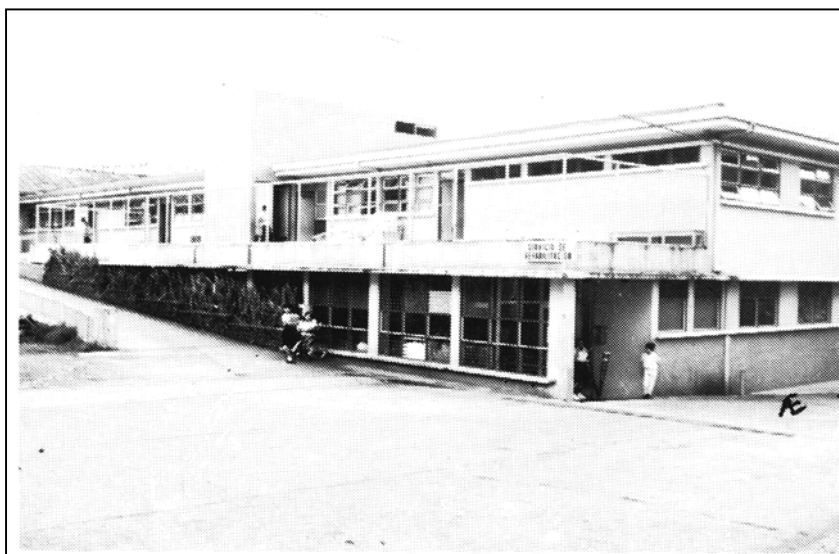
Servicio de Rehabilitación del Hospital San Juan de Dios. Hoy se atienden también pacientes de la sección de Medicina, ante el inminente acto de demolición del edificio que se usaba para esos pacientes -enero-marzo 1994
