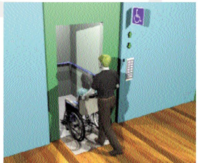
El interior de la cabina debe contar con agarraderas en los lados libres de la puerta a 90 cm de altura colocados con una separación mínima de 5 cm de la pared, además el piso debe ser firme, antideslizante y sin irregularidades.
