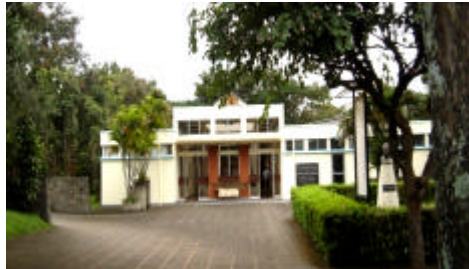
Fachada del Edificio Técnico Administrativo, Hospital Nacional Psiquiátrico
